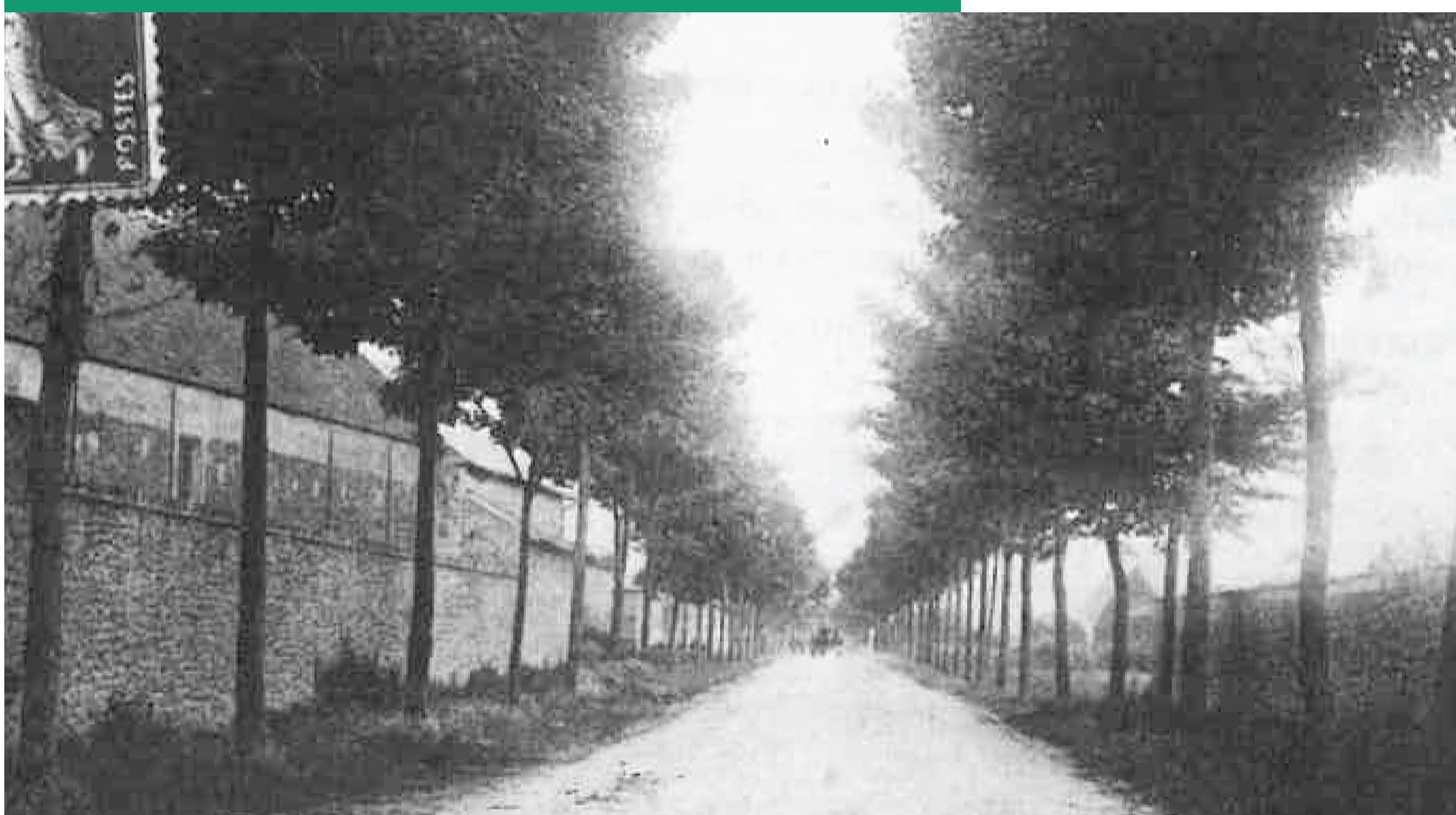
Entrée avenue Charles de Gaulle
