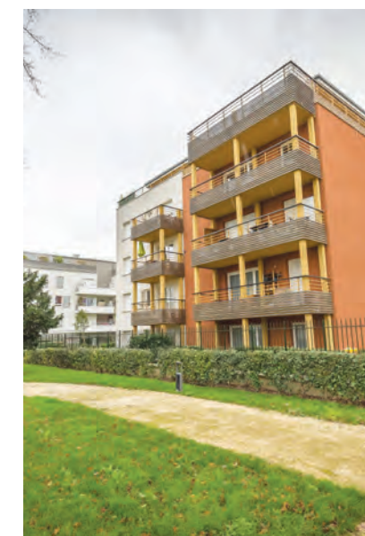
Constructions dans le but de respecter les objectifs fixés par l'État
