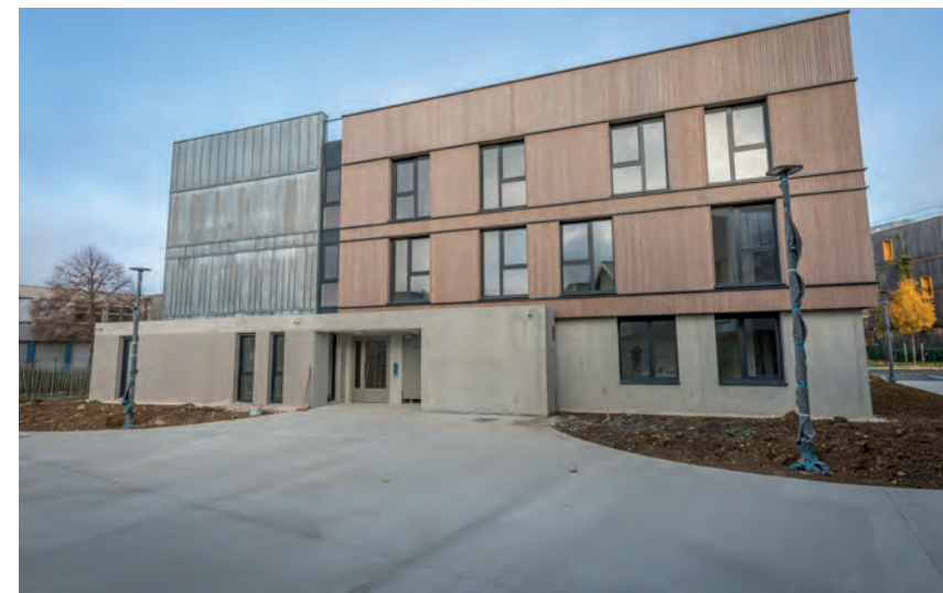
La résidence pour jeunes actifs accueillera ses premiers locataires courant janvier
